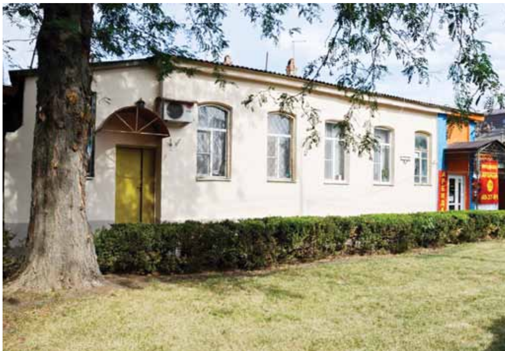
Дом дежурного штаб-офицера при штабе Кавказской линии. Здесь М. Ю. Лермонтов получал приказы и распоряжения в период своей службы на Кавказе. Здание построено в 1830 году (фото 2014 года).
